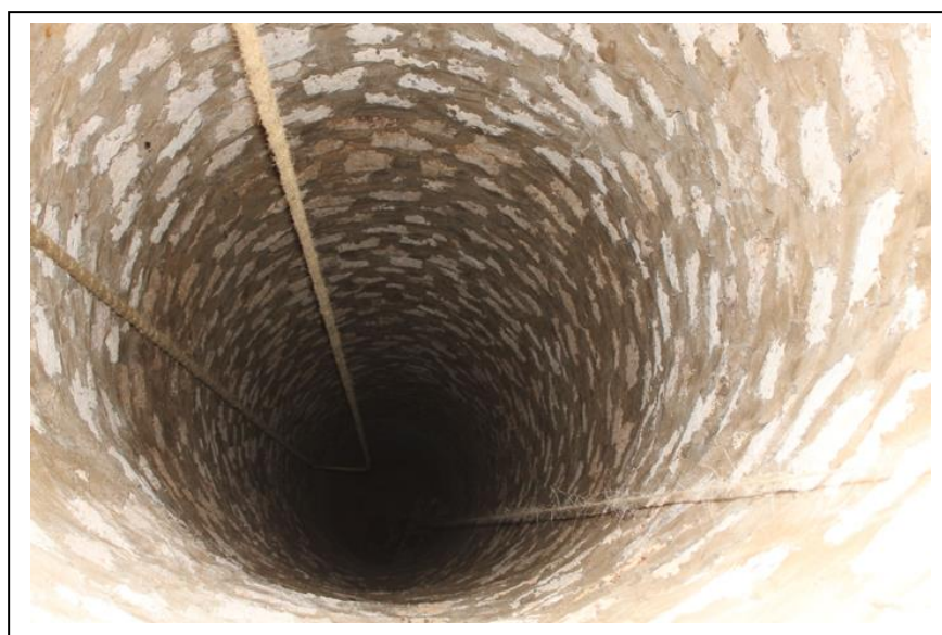
Waterput in aanbouw
